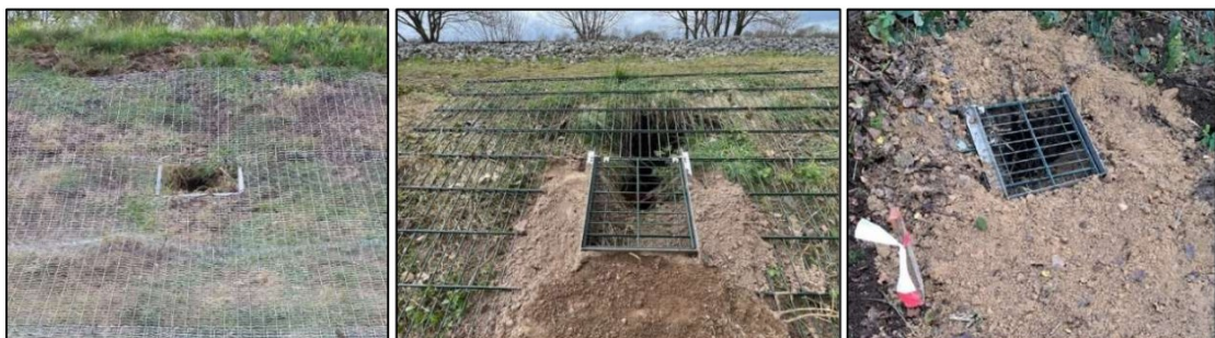
Afbeelding 4.8 Aanbrengen dassengaas en terugslagklep op een te saneren dassenburcht.
