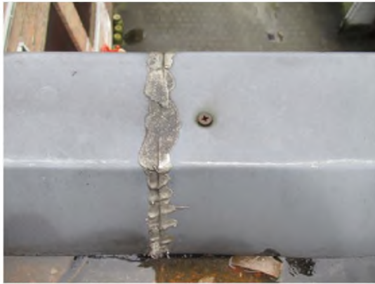
dak no. 11: deklijst in het zicht met schroeven vastgezet (2024)
