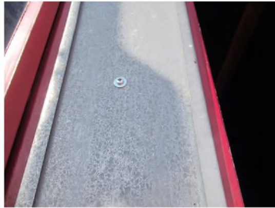
gevel no. 5: zink in het zicht vastgeschroefd (2022)
