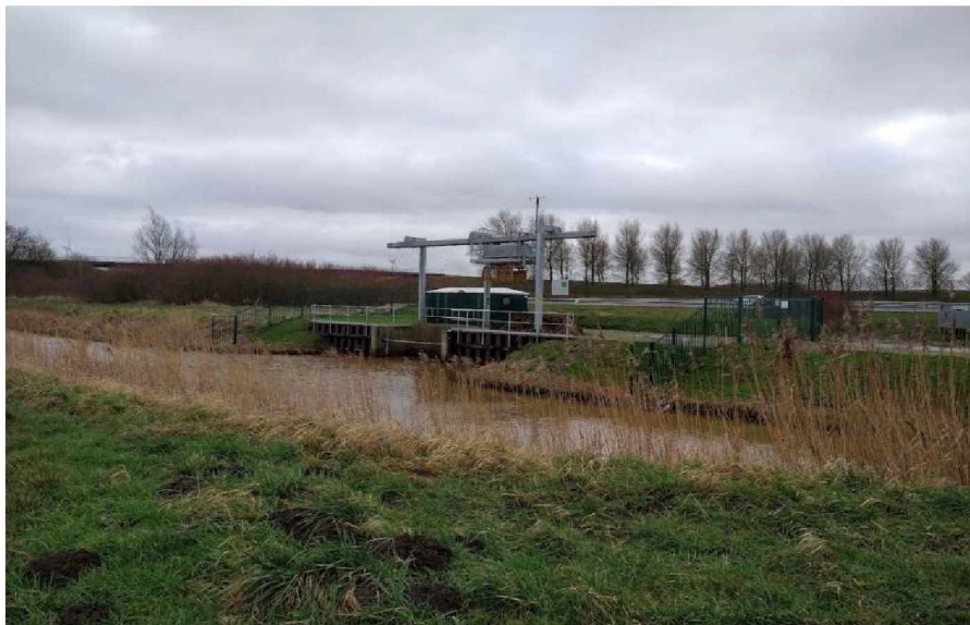
Figuur 3 Gemaal Driepolders, ten oosten van de snelweg A4 (kijkrichting foto is zuid-west)
