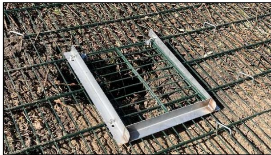
Afbeelding 4.6 Detail rasterframe van ca. 150x150cm met one-way klep van minimaal 30x30cm.
