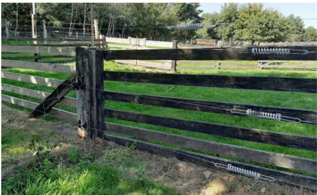
Wolfwerend hekwerk bij schaapskooi (Foto: 5.1.2.e)
