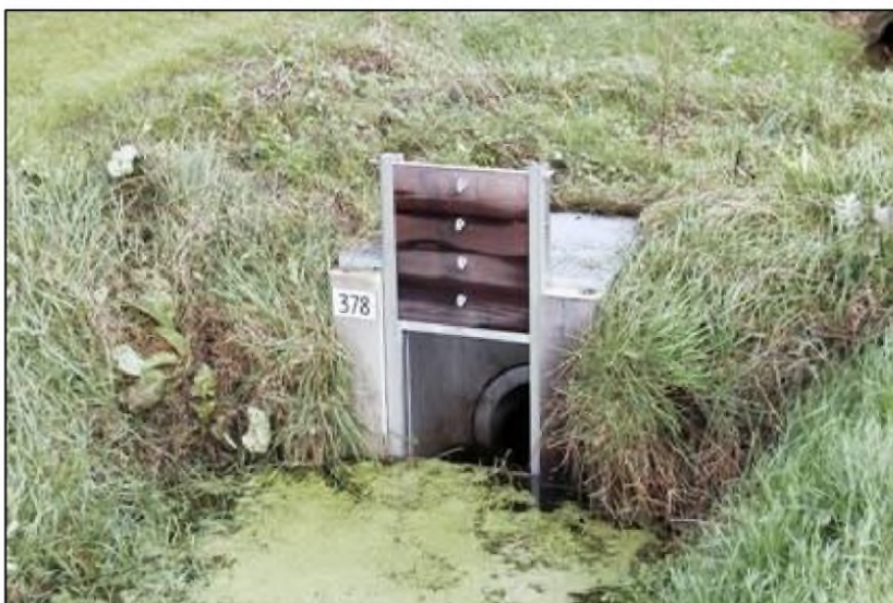
Figuur 2: Impressie te plaatsen stuw
