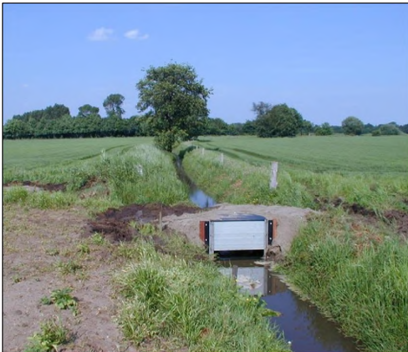
Figuur 1: Impressie te plaatsen stuw
