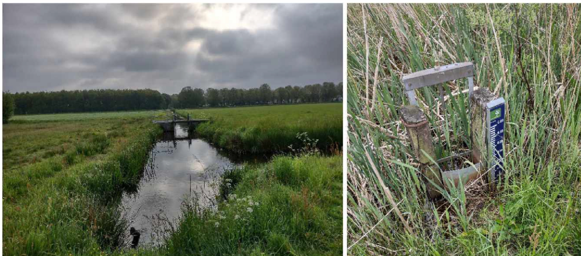
Figuur 3-11: Oppervlaktewatersysteem Gastels Laag. Links stuw waterschap Brabantse Delta aan de oostzijde. Rechts stuwtje Staatsbosbeheer zuidelijk deel van het natuurgebied. Foto's veldbezoek 19 mei 2021.
