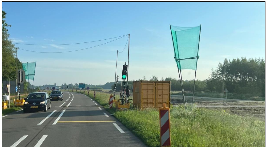
Afbeelding 2 Voorbeeld kunstmatige vleermuisvoorziening (globale dimensionering: minimale doorsnede van 2 meter, minimale hoogte 3,5 meter).
