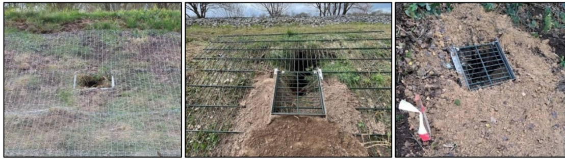
Afbeelding 3.17 Aanbrengen dassengas en terugslagklep op een te saneren dassenburcht.
