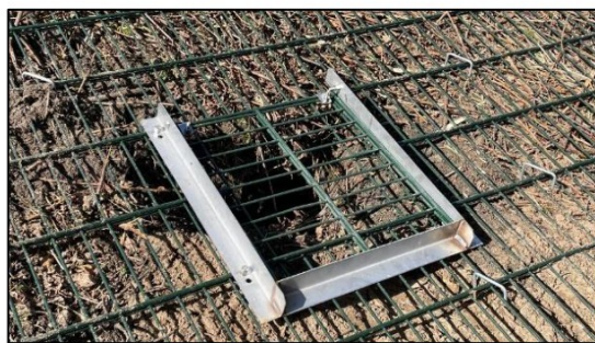
Afbeelding 3.15 Detail rasterframe van ca. 150x150cm met one-way klep van minimaal 30x30cm.
