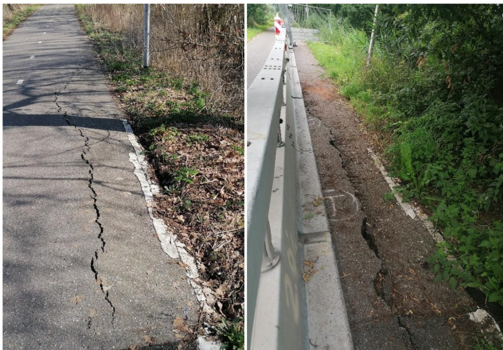
Afbeelding 1.1 Locatie van toenemende verzakking ter plaatse van de hoofburcht in maart en juli 2021.
