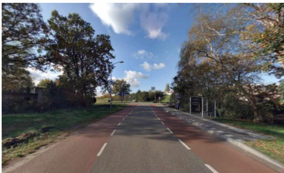
Figuur: 4.4: Huidige situatie Bosschebaan (bron: Cyclomedia).
