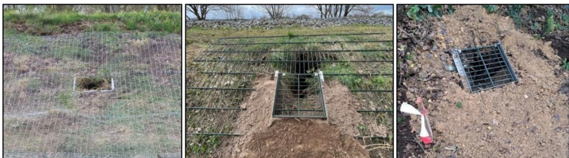
Afbeelding 4.9 Aanbrengen dassengaas en terugslagklep op een te saneren dassenburcht.
