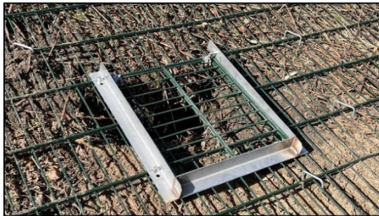
Afbeelding 4.7 Detail rasterframe van ca. 150x150cm met one-way klep van minimaal 30x30cm.
