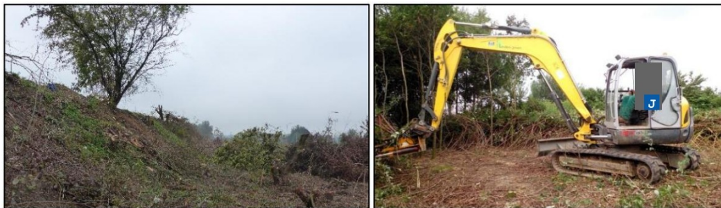
Afbeelding 4.8 Voorbeeld ontmoedigen te saneren dassenburcht door verwijderen begroeiing.
