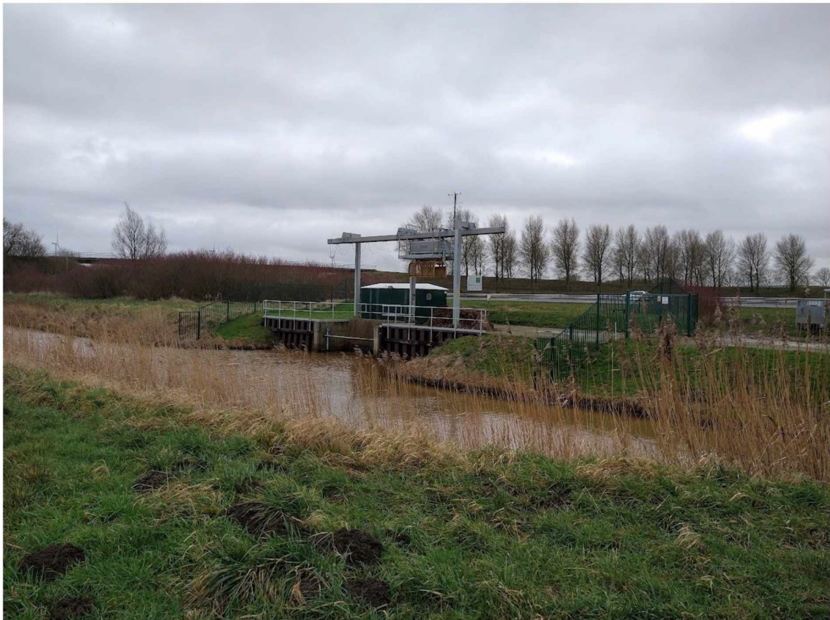
foto: Gemaal Driepolders , ten oosten van de snelweg A4 (kijkrichting foto is zuid-west)
